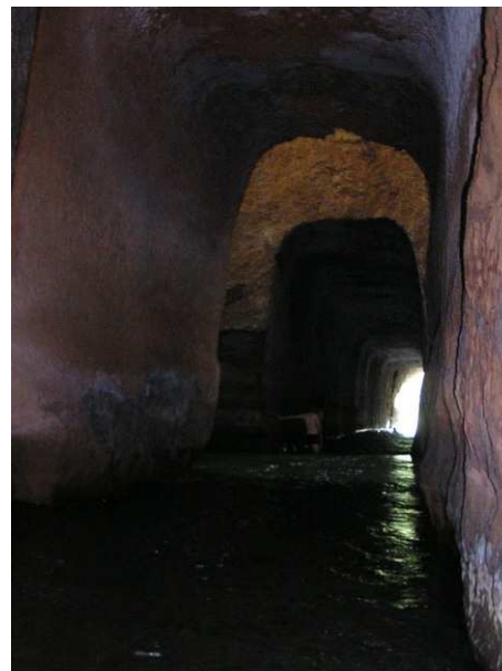
„Tunel“ Průrvy Ploučnice
